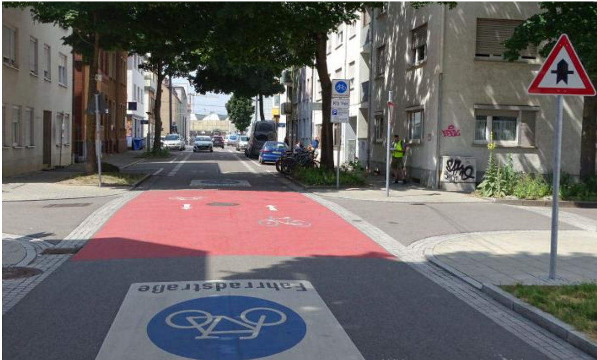
Abbildung 5: Knoten mit angehobener roter Fahrbahnfläche und Bevorrechtigung in Ulm. 5
