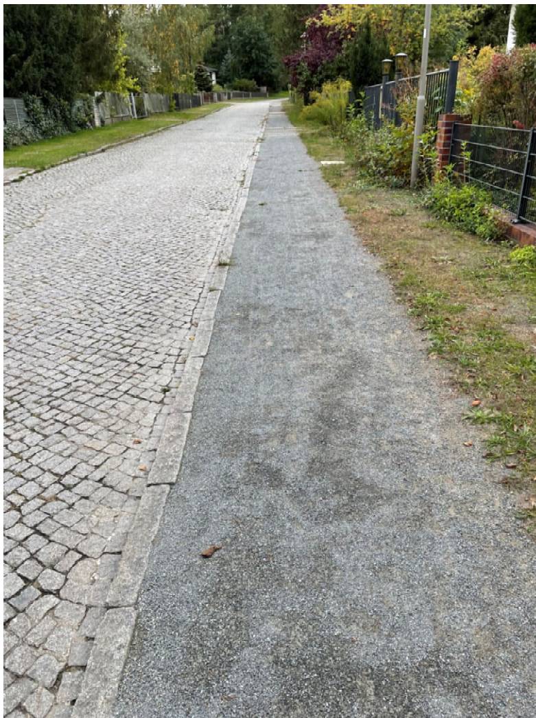
Abb. 22: Unbefestigter Gehweg im Seitenraum einer Straße mit einer Fahrbahn aus Natursteinpflaster
