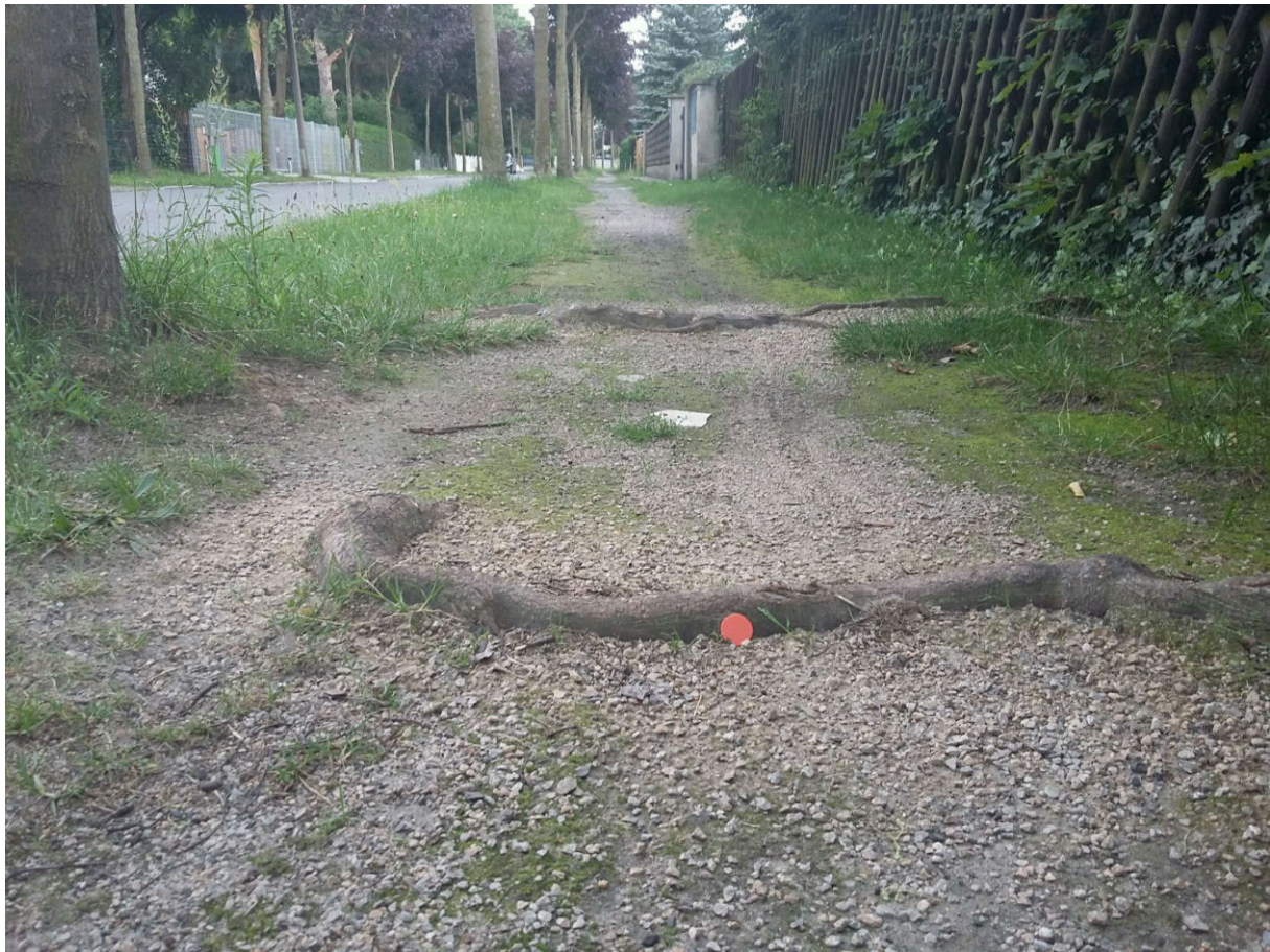
Abb. 25: Unbefestigte Gehwege mit altem Baumbestand
