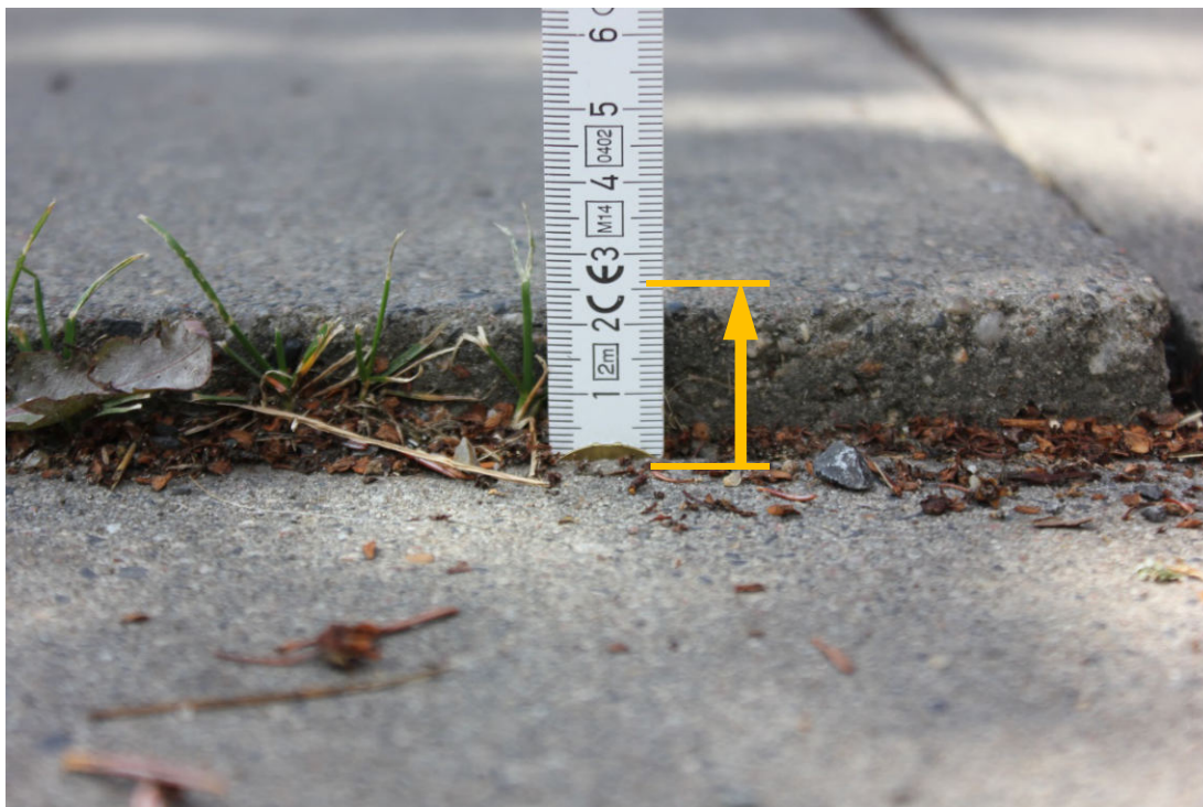
Abb. 2: Beispielmessung bei einem Plattenversatz knapp unter der Bagatellgrenze von 2,5 cm
