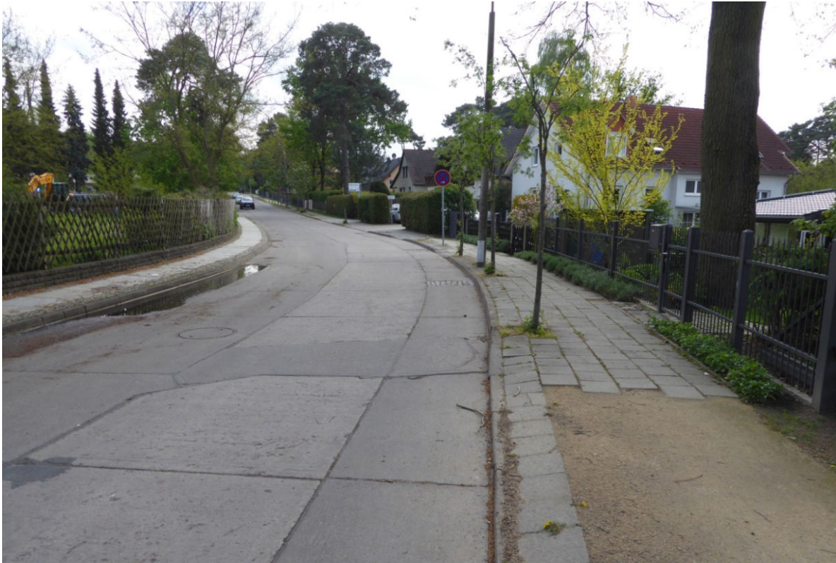
Abb. 15: Sehr schlechter Gehwegzustand in der Weichselstraße
