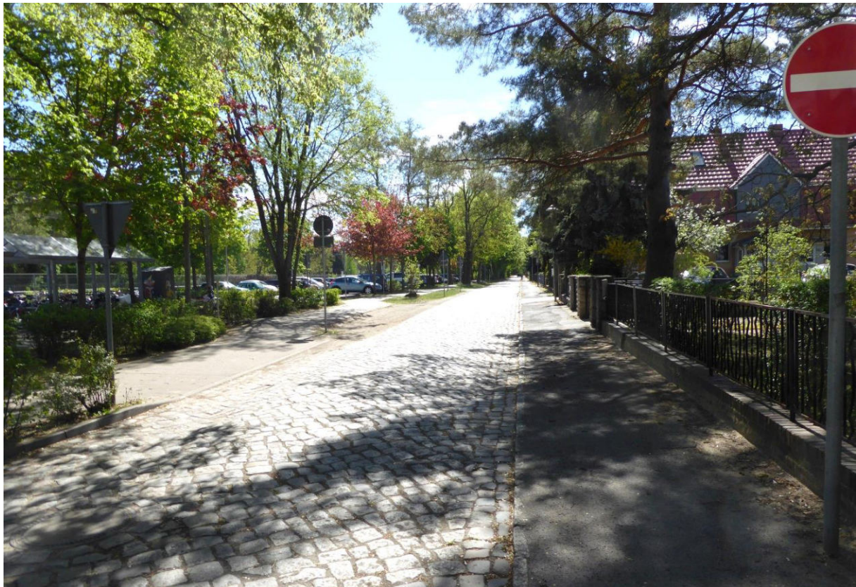
Abb. 16: Sehr schlechter Gehwegzustand in der Bahnstraße
