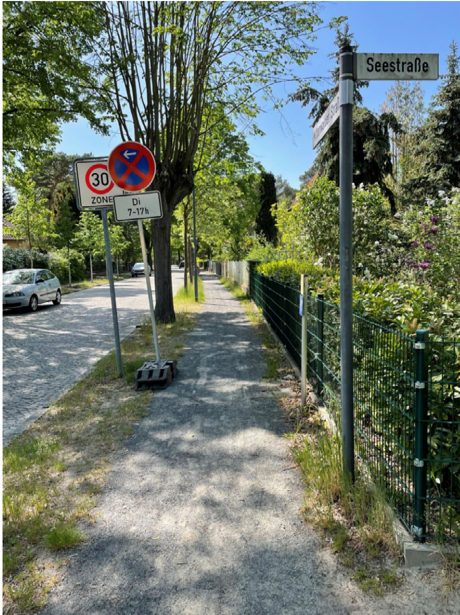
Abb. 7: Neuer Gehweg in der Mittenwalder Straße
