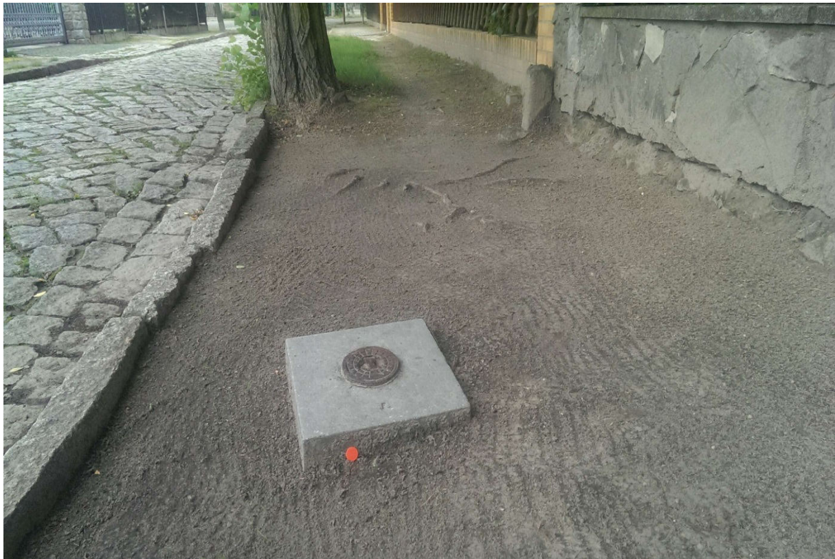
Abb. 28: Freigelegter Wasserschieber im Gehwegbereich
