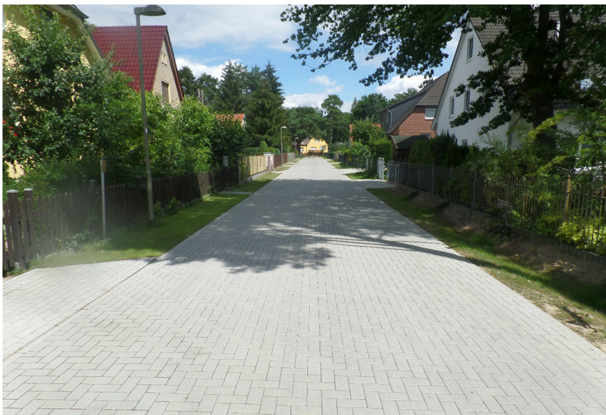
Abb. 23: Neubau einer Mischverkehrsfläche in der Waldstraße
