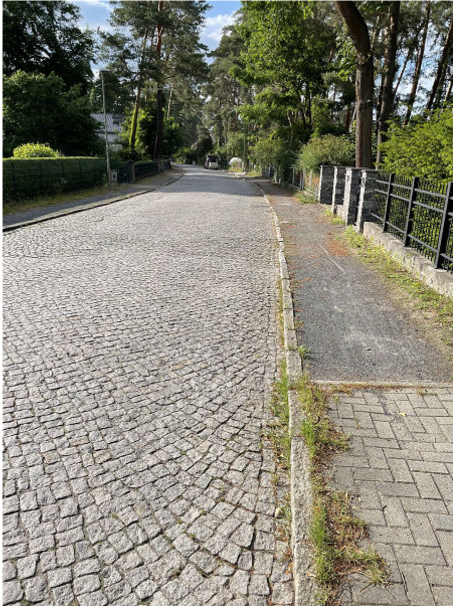
Abb. 13: Sanierte Gehwege in der Fasanenstraße
