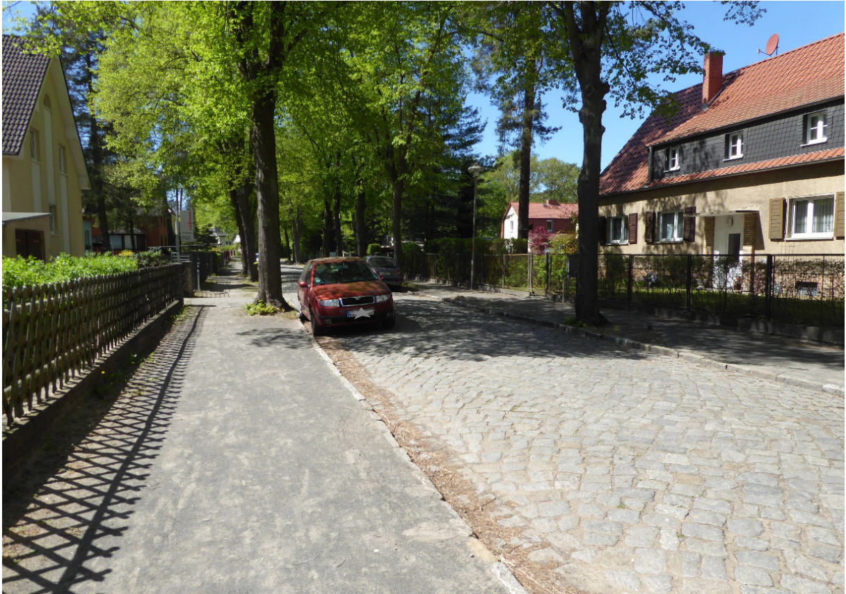
Abb. 31: Profilierung und Befestigung der Gehwege durch ein Sand-Splitt-Gemisch in der Moselstraße
